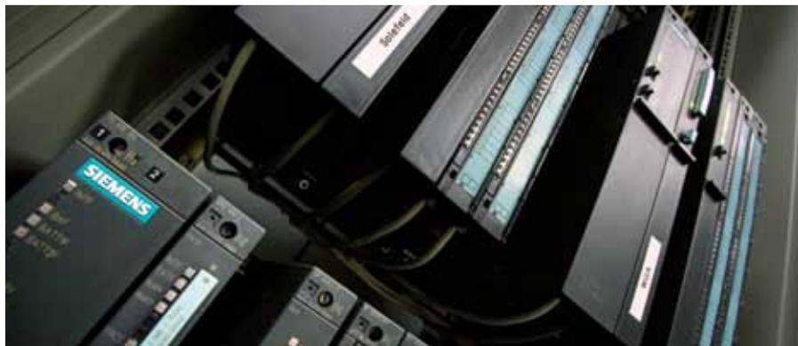
**Für sichere Kommunikation im unternehmensweiten Netzwerk sorgen PROFINET-fähige Module.**
