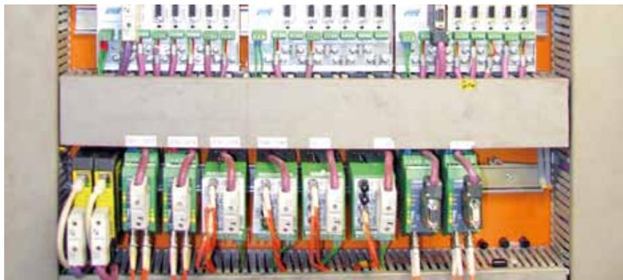
Der integrierte Webserver und die Ethernet-Funktionalität von Turcks Interface PB-XEPI ermöglichen die bequeme Diagnose des PROFIBUS-Netzes vom Büro aus.
