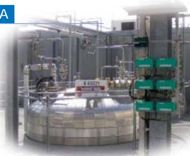
Feldbusbarrieren, wie hier im Bild, sorgen für den Durchbruch des Feldbusses im Ex-Bereich.
